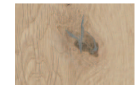
パテ埋め 節・割れ等をパテで補修しています
